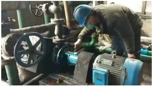
图为热电员工检查供电设备。
